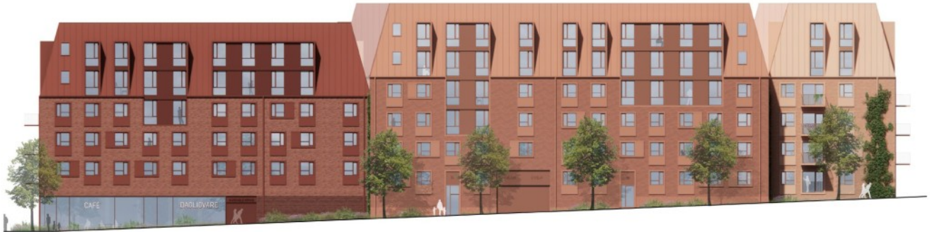
Figur 30. Facade mod øst, der vender mod Frydenlunds Allé
