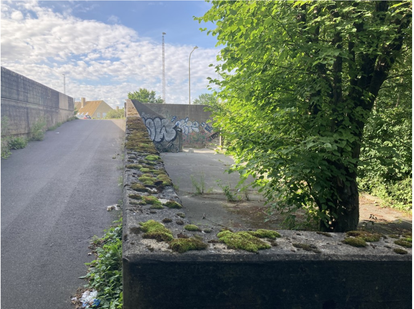
Billedet viser cykelrampeanlægget set fra rampen mod Viborgvej.
