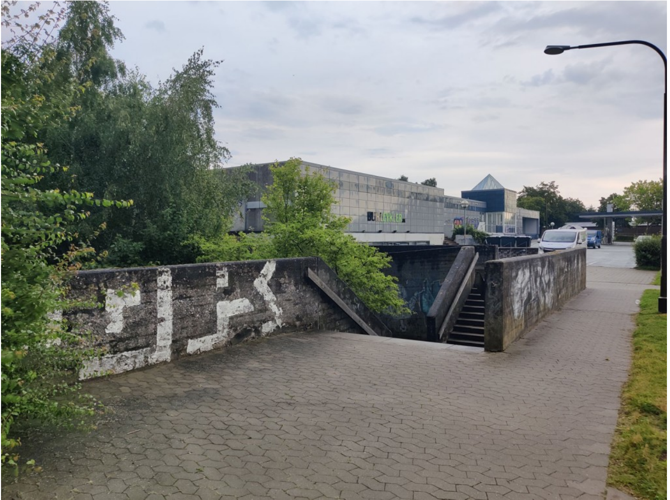
På billedet ses trappeadgangen mellem Frydenlund Centret og cykel- gangstien. Betonvægge udgør et værn omkring trapper og over tunnellen.
